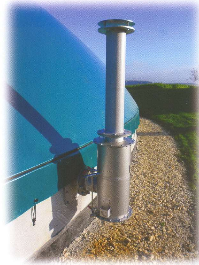
Valvola di sicurezza (sovra/sotto pressione)
