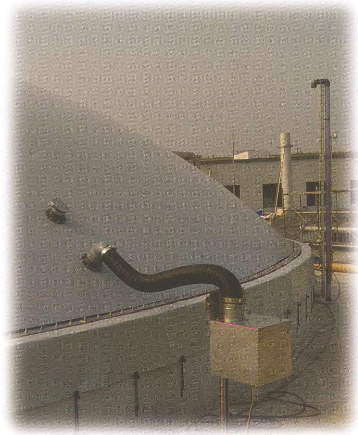
Soffiante e barra di livello con sensore
