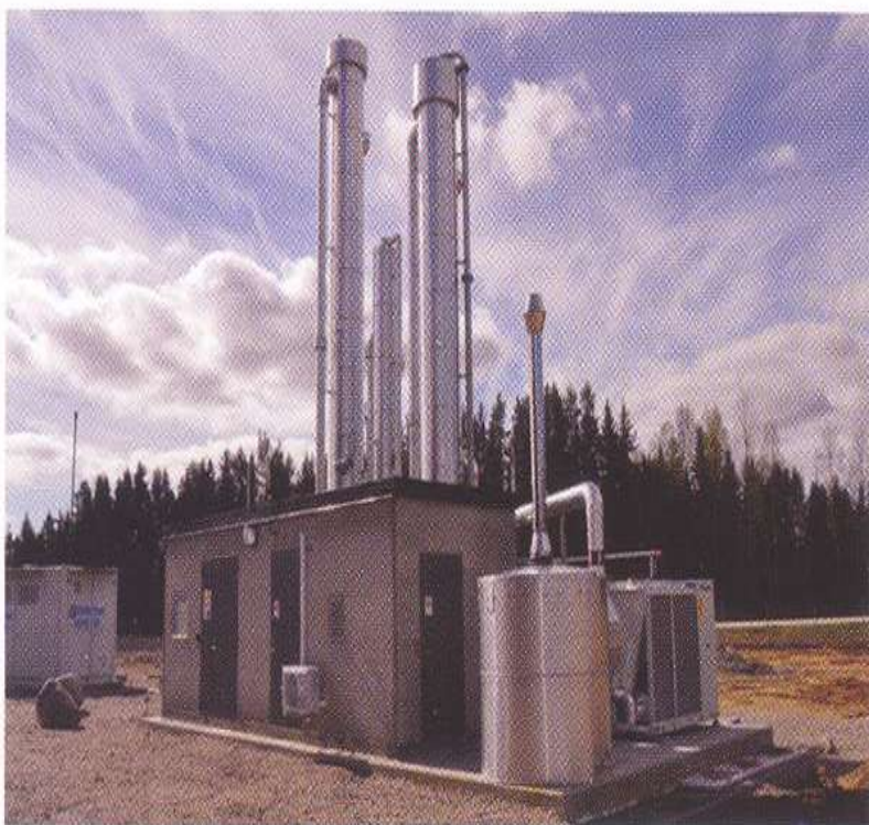
Malmberg COMPACT® GR BAS 1-3 da 100 a 650 Nm 3 /h di biogas in ingresso.
